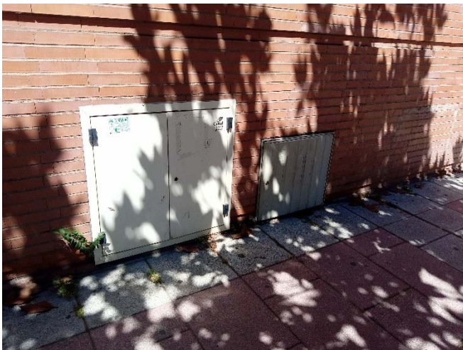
ARMARIOS DE ACOMETIDA EN AVENIDA DE LAS FRONTERAS
